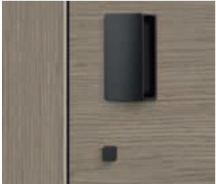
Zamontowany zamek magic magnetic z uchwytem KONZERA i z dodatkowym zamkiem WC
