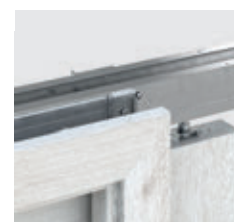
construcția casetei metalice
